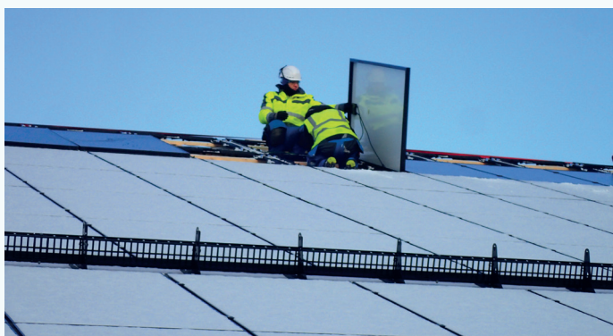
Montering av solcellepanela på taket av ZEB-laboratoriet vart gjort vinteren 2019/2020 slik at vi kunne starte hausting av solenergi i april, eit halvår før bygget var ferdig. Foto: Tore Kvande
