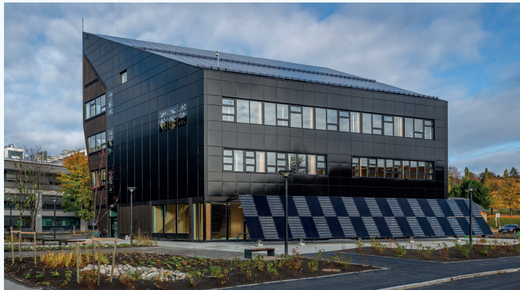
ZEB-laboratoriet på Gløshaugen i Trondheim har bygningsintegre solceller på alle flater med stor nok soltilgang. Resten av fasadane har trekledning eller kledning av svarte plater. Foto: m.c.herzog / visualis-images
