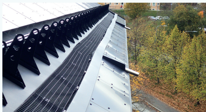
Takavslutning med «varm» takrenne, snøfangarar, løvsamlar og nødoverløp. Foto: Tore Kvande
